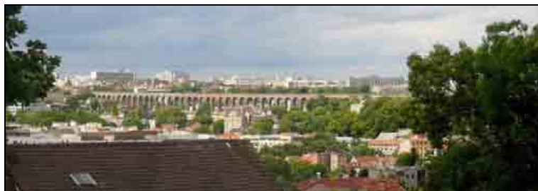
Vue sur l'aqueduc du boulevard de la Vanne
